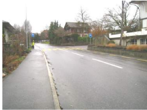
Abbildung 26 Uettligen, Einmündung Leimerenweg, gegen Westen
